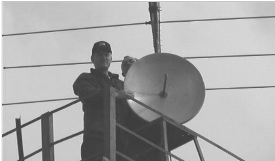
* Arvo, ES5MC ja Juhani, ES5QX paigaldavad 10 GHz antenni
